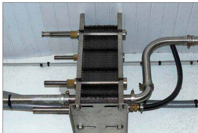
Pré-refroidisseur à plaques
