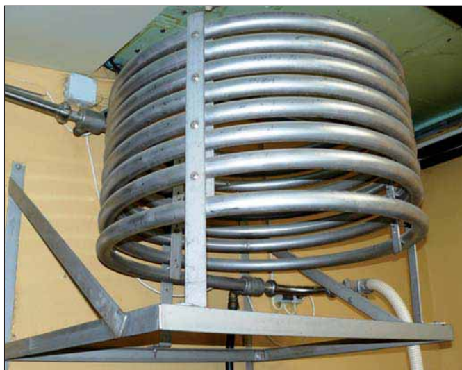
Pré-refroidisseur tubulaire
